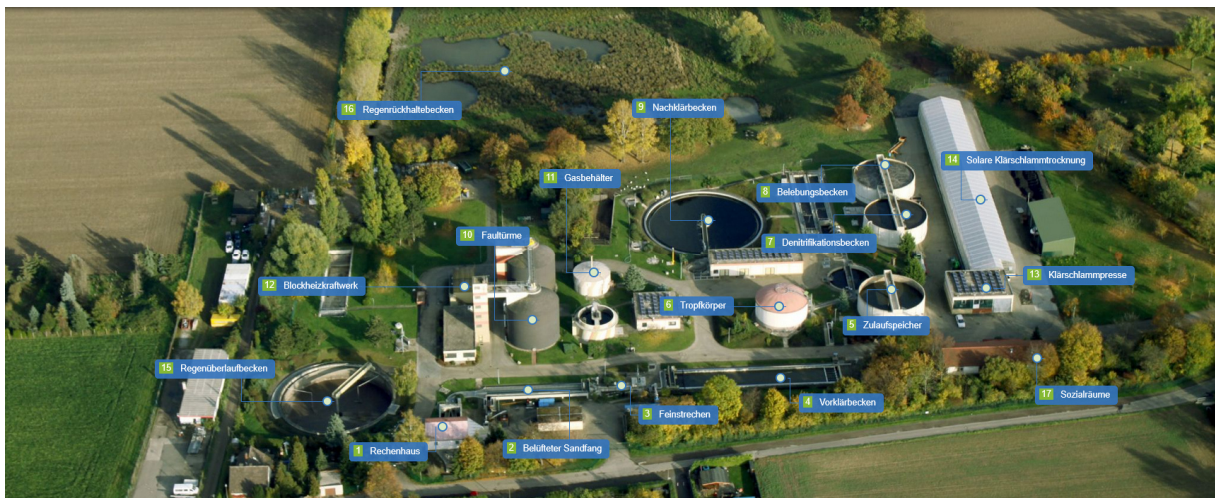
Abbildung 23 Kläranlage Grünstadt Quelle: [EBG 2025]
